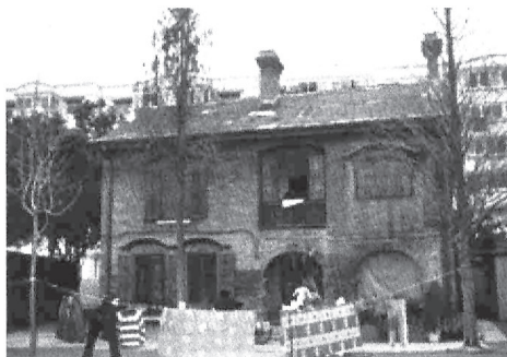
图 6 淮安市清河区基隆东巷 5 号福音堂
